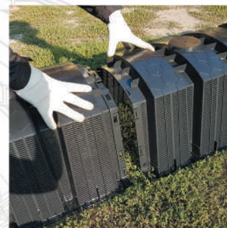
8. Połączyć tunele
