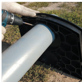
5. Zabezpieczyć wkrętem
