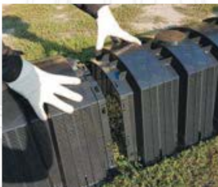
8. Połączyć tunele
