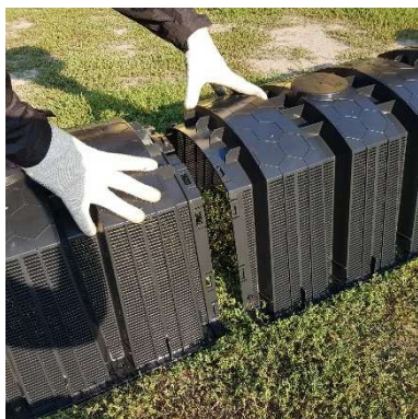
8. Połączyć tunele
