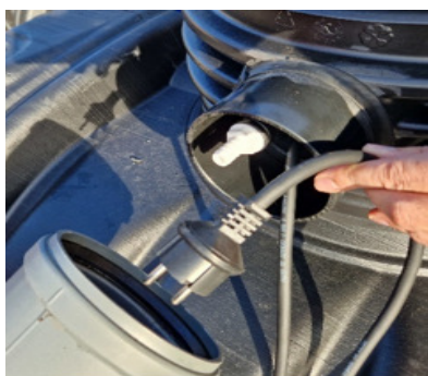
Gaisa šļūteni un sūkņa kabeli ievietot aizsargcaurulē Ø110 mm.
