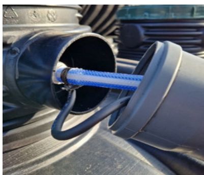
Pievienojiet gaisa šļūteni, nostiprinot ar savilcējgredzenu.
