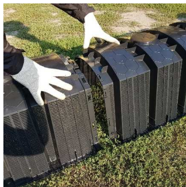
8. Połączyć tunele
