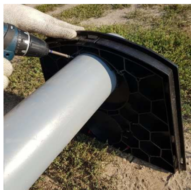
5. Zabezpieczyć wkrętem
